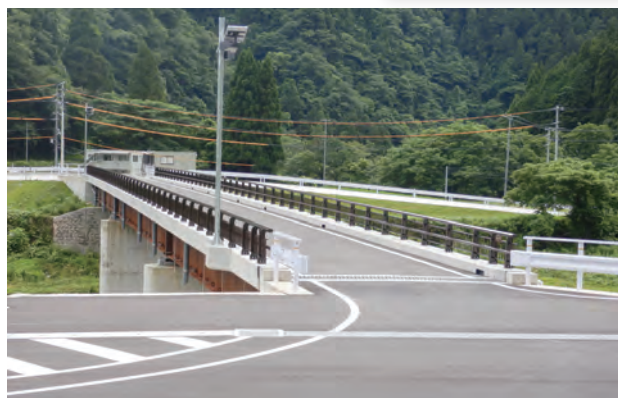
▲供用開始した小原橋
