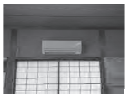
石自治会空調設備更新事業
