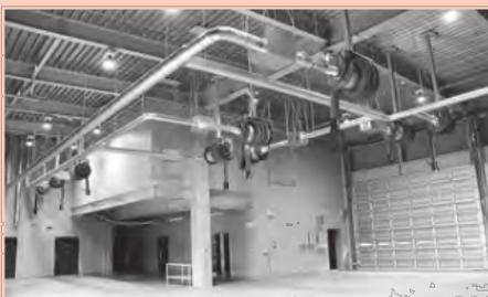
▲車庫内に整備した排煙設備。車両の排ガスを浄化します。
