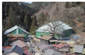
解体修理が進む菅谷たたら山内
