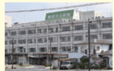
新棟建設する雲南市立病院
