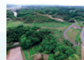
造成中の神原企業団地(加茂)
