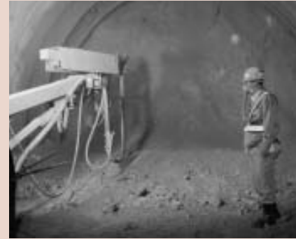
仮排水路の掘削作業
