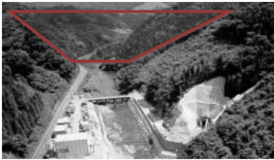
ダムサイト（堤防）予定箇所
