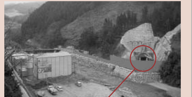
仮排水路の吐け口
