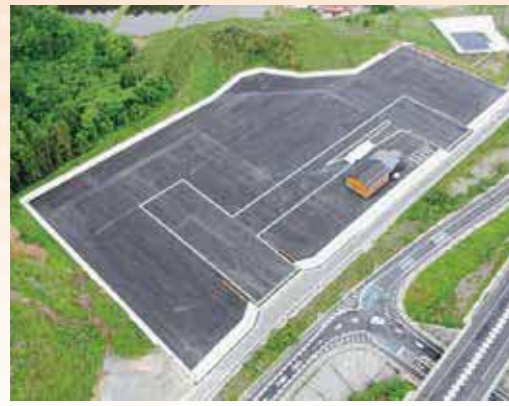
▲雲南吉田木材流通拠点施設（ストックヤード）
