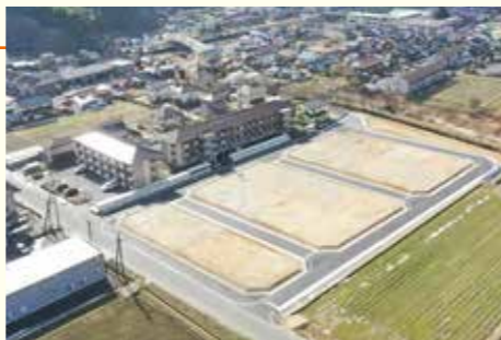
▲新たに整備された新庄住宅団地
